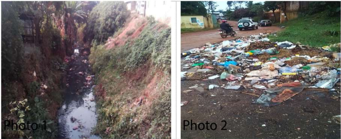
Planche 1: (Photo 1 Déchets obstruant les cours d’eaux) ; (Photo 2 : déchets obstruant les voies de communication)
