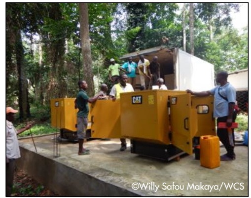
Livraison et installation de deux nouveaux générateurs pour l'alimentation électrique de la base de Bomassa
